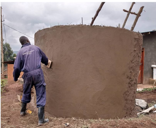
Bau eines Wassertanks © Dieter Beller
